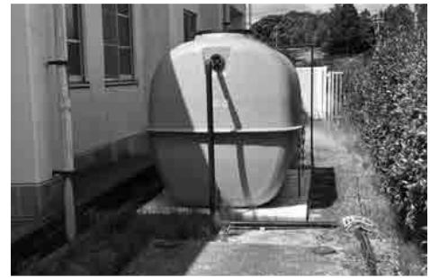
▲ 仮設の浄化槽
